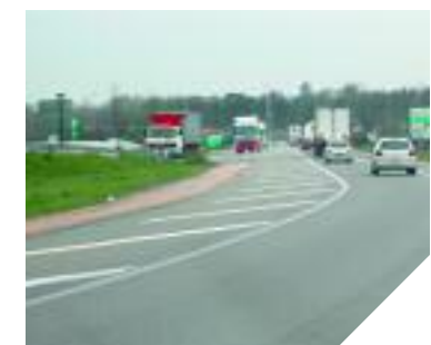
POINT ROUGE Urgence sur le contournement sud de Mâcon : le trafic entre l'ARCEA et l'A.40 se reporte sur une RN6 toujours plus saturée.
